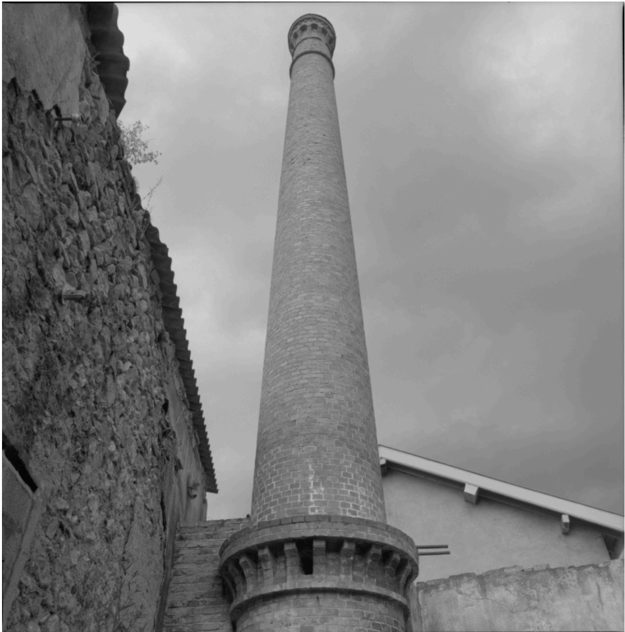
Elévation de la cheminée attenante au garage et à l'atelier.
