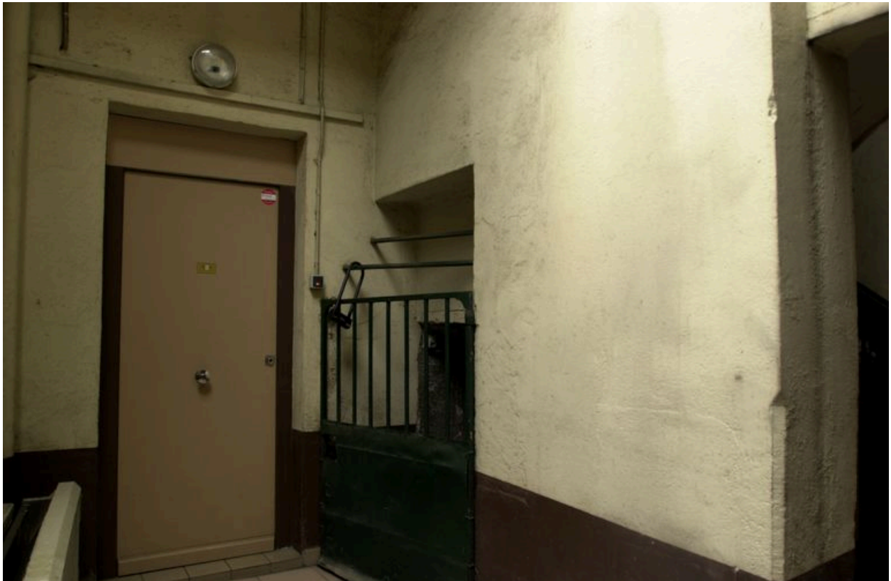
Le couloir d'entrée : au fond la porte vers AH 6, à droite l'accès à la cave et à l'escalier
