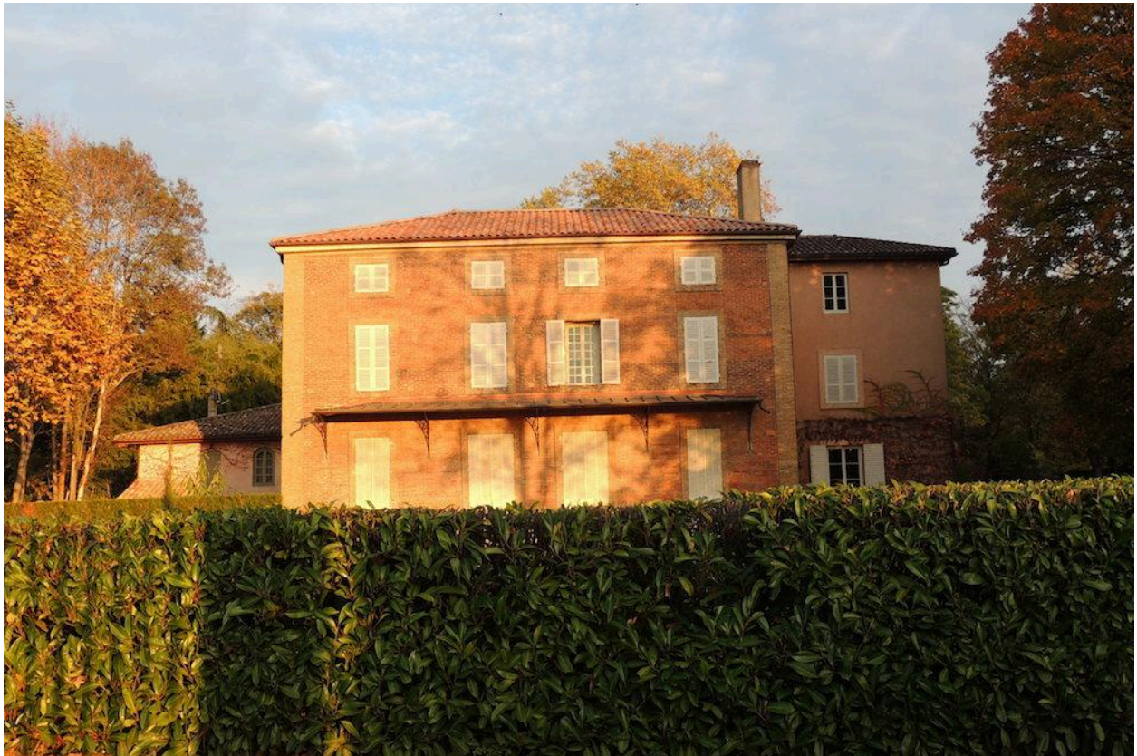
Élévation occidentale vue depuis la route
