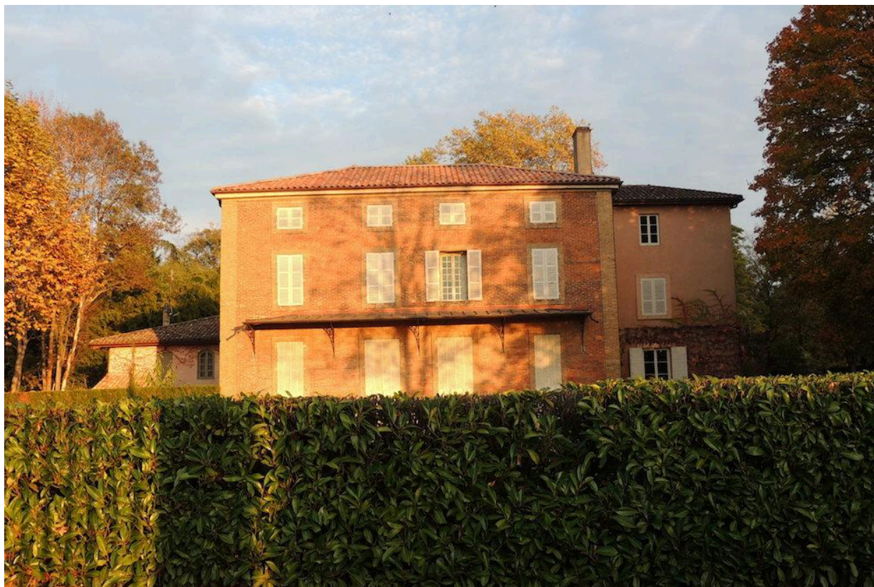
Élévation occidentale vue depuis la route
