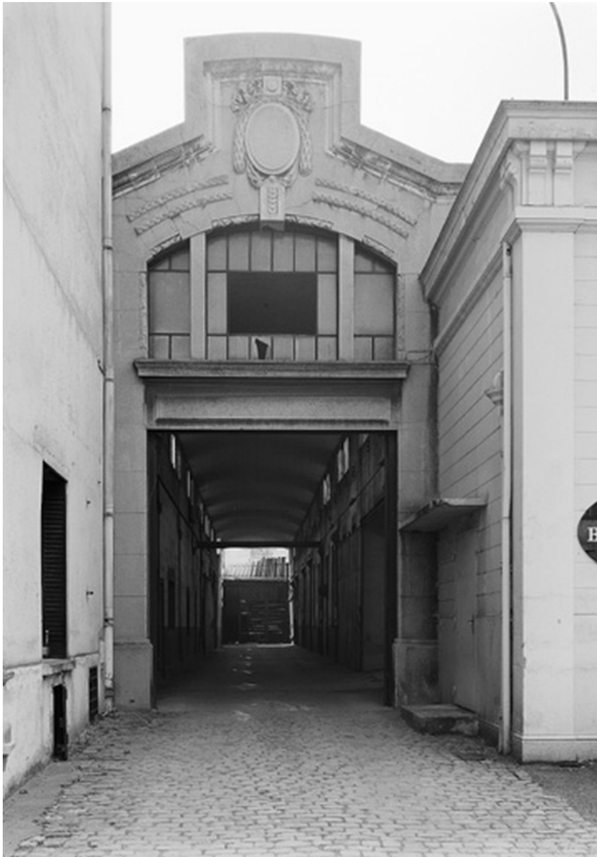
Entrée des bâtiments d'exploitation
