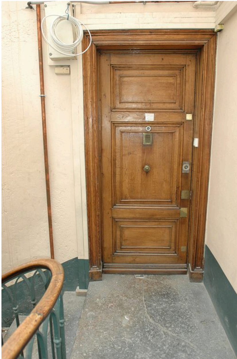
Porte palière du dernier étage
