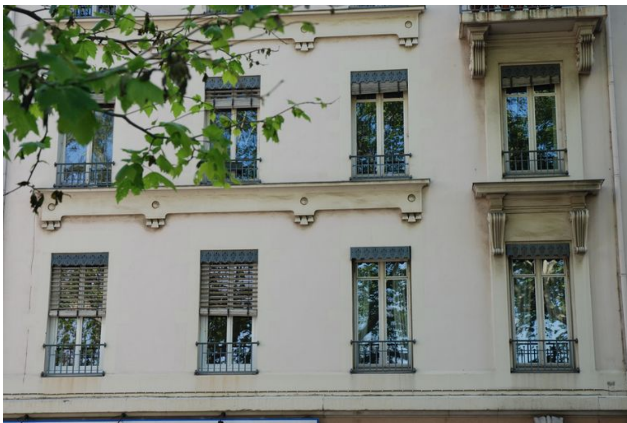
Détail de l'élévation sur la rue Cavenne
