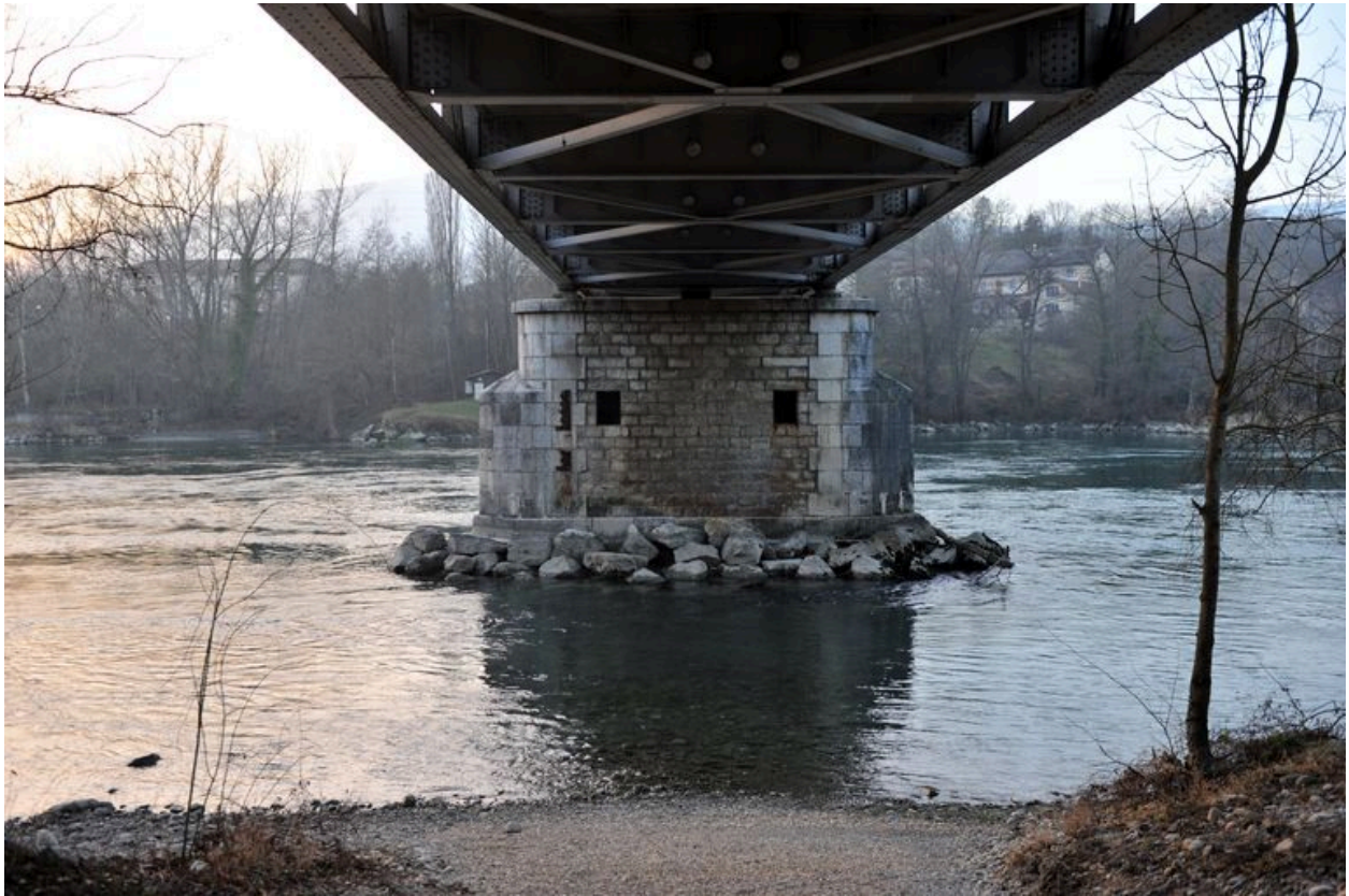
Vue de dessous, tablier et pile (depuis la rive gauche)
