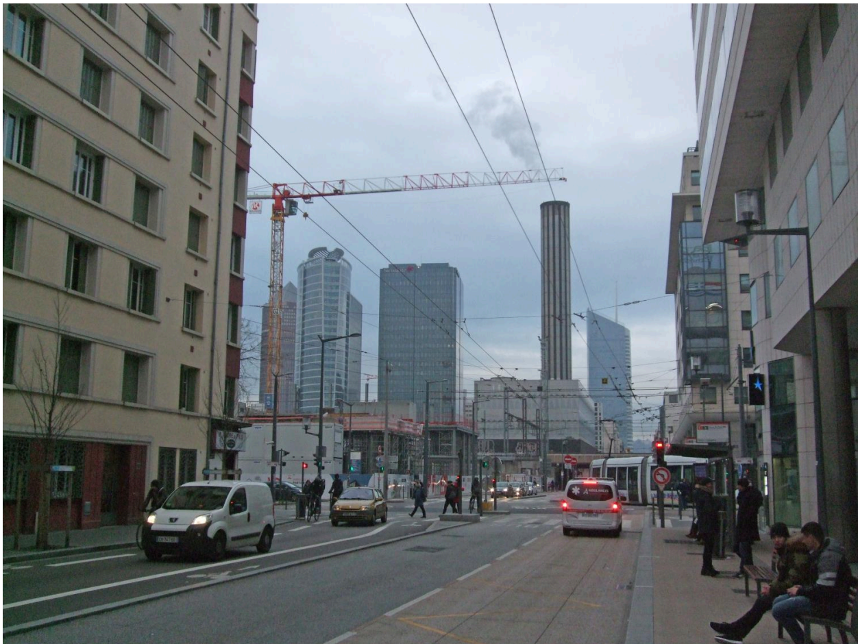
Vue d'ensemble est (cours Lafayette)
