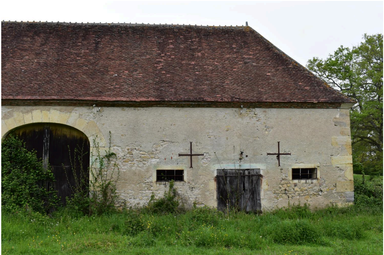
Grange nord-ouest du château de Beauregard
