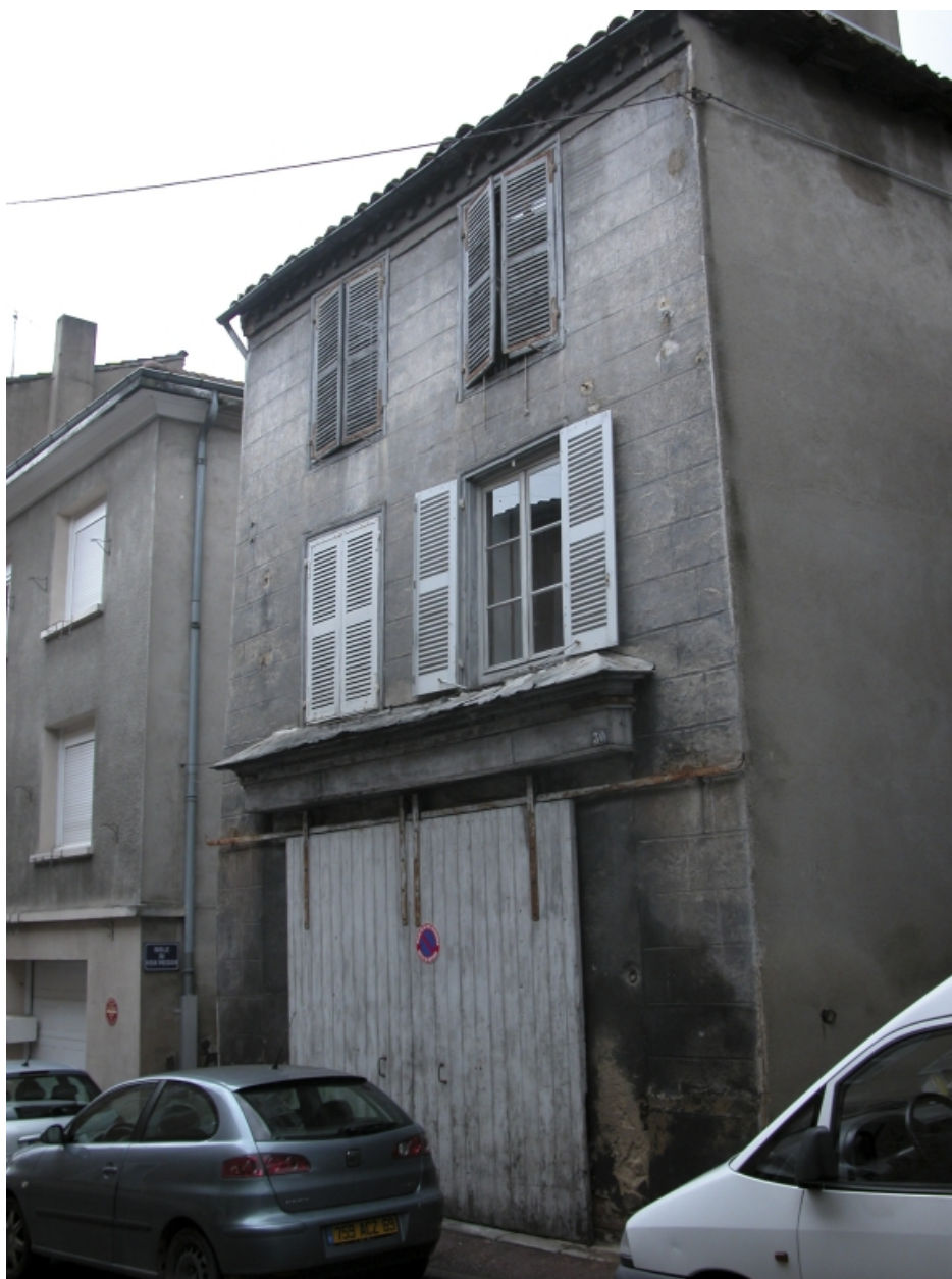
Îlot 2. Saint-Jean (rue) 30. Vue générale de la façade sur rue.
