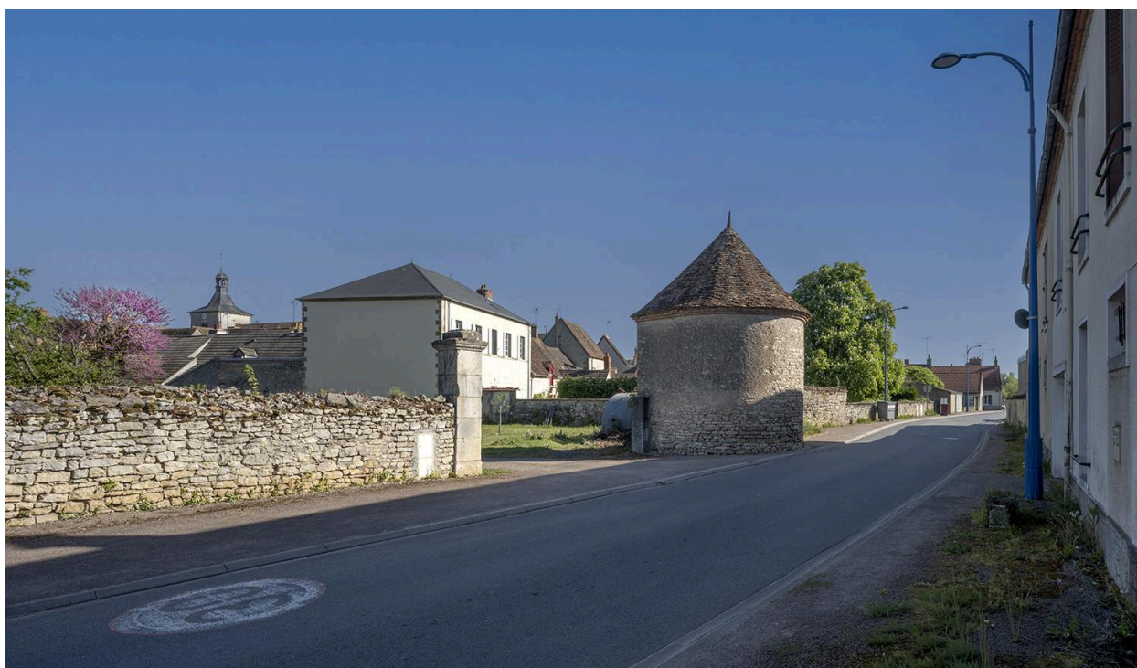
Tour, vestige de la fortification d'agglomération du Veudre, parcelle cadastrale B01 :123, donnant sur la rue Tour des murs. Vue vers le nord.
