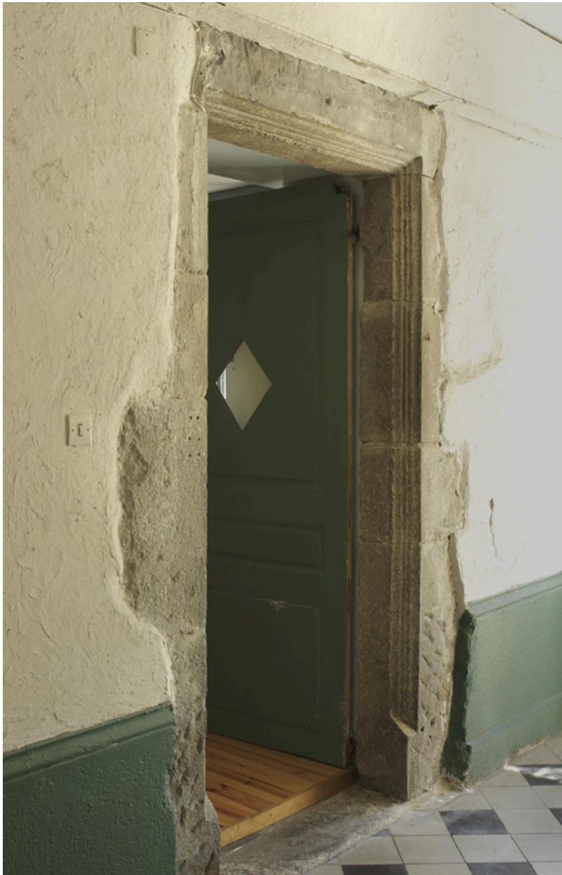
Porte intérieure à encadrement mouluré.
