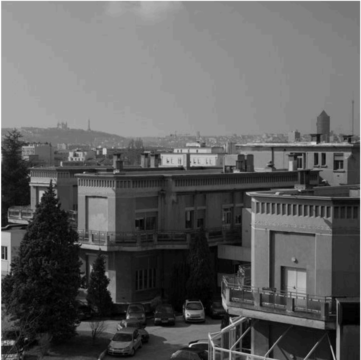
Le pavillon S, vue des trois ailes nord - sud depuis le sud-est
