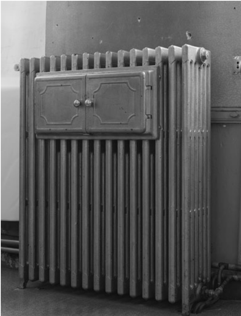
Radiateur avec chauffe-plat, en emploi dans la bibliothèque.
