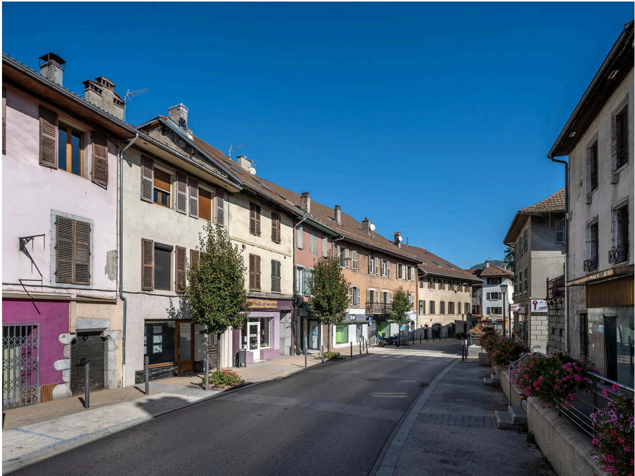
Vue de la rue Carnot depuis l'angle de l'allée du four.
