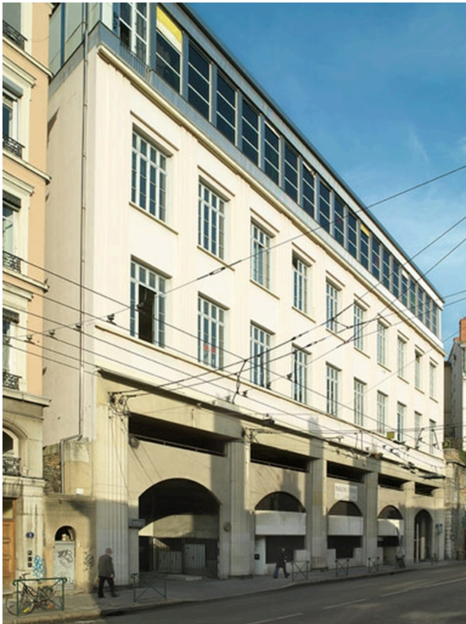
Vue d'ensemble façade sud-ouest (rue Terme)
