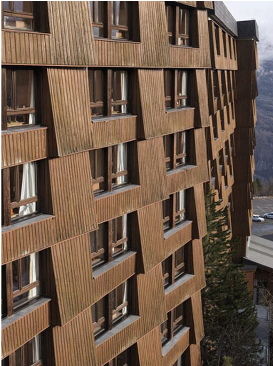
Vue de la façade sud
