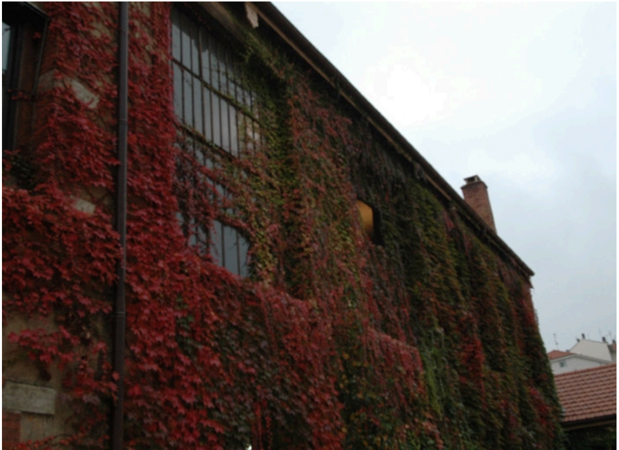
Détail baies des ateliers à métiers à bras (1er étage)
