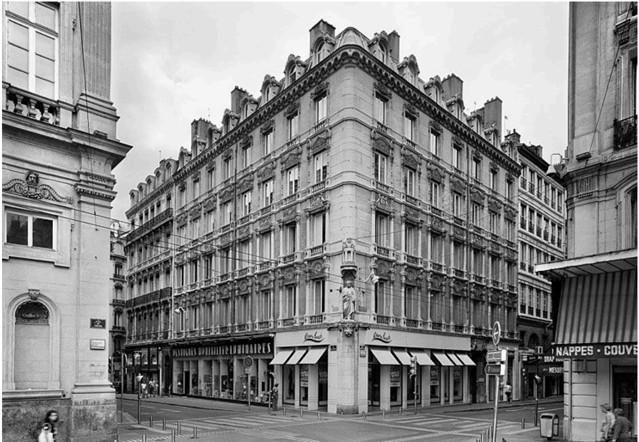
Vue générale des façades sur rue
