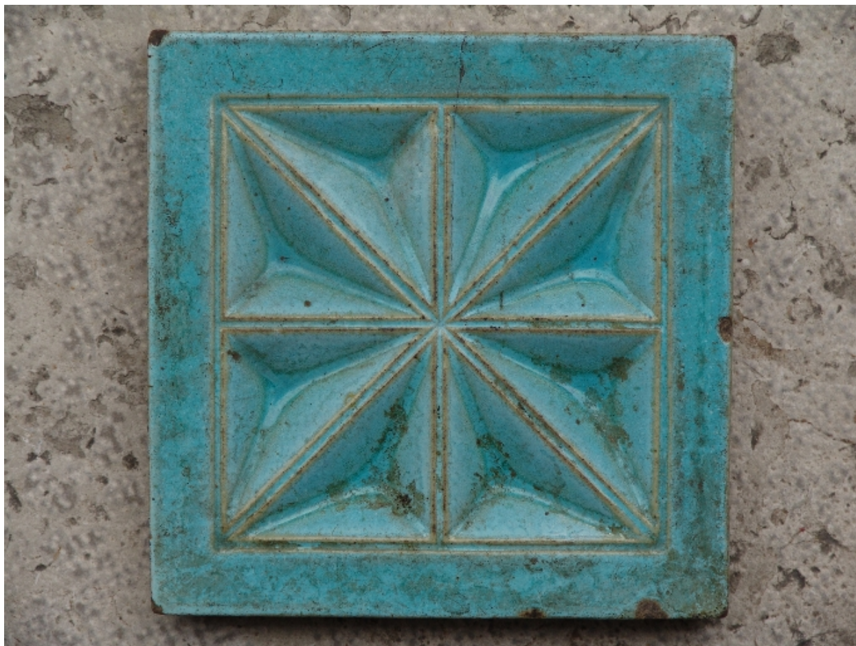
Ancien carreau de faïence de la façade
