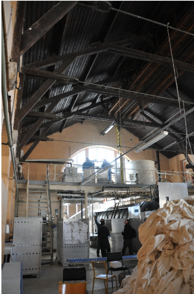
Vaisseau central, vue vers l'ouest : tunnel de lavage et plate-forme métallique
