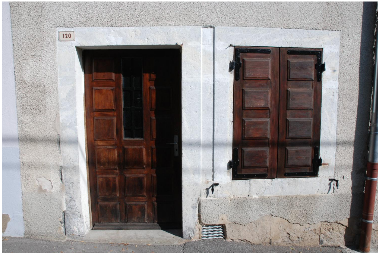
Cellier viticole, dit sarto (2018 E3 1329). Détail de la façade, encadrements partagés de la porte et de la fenêtre.
