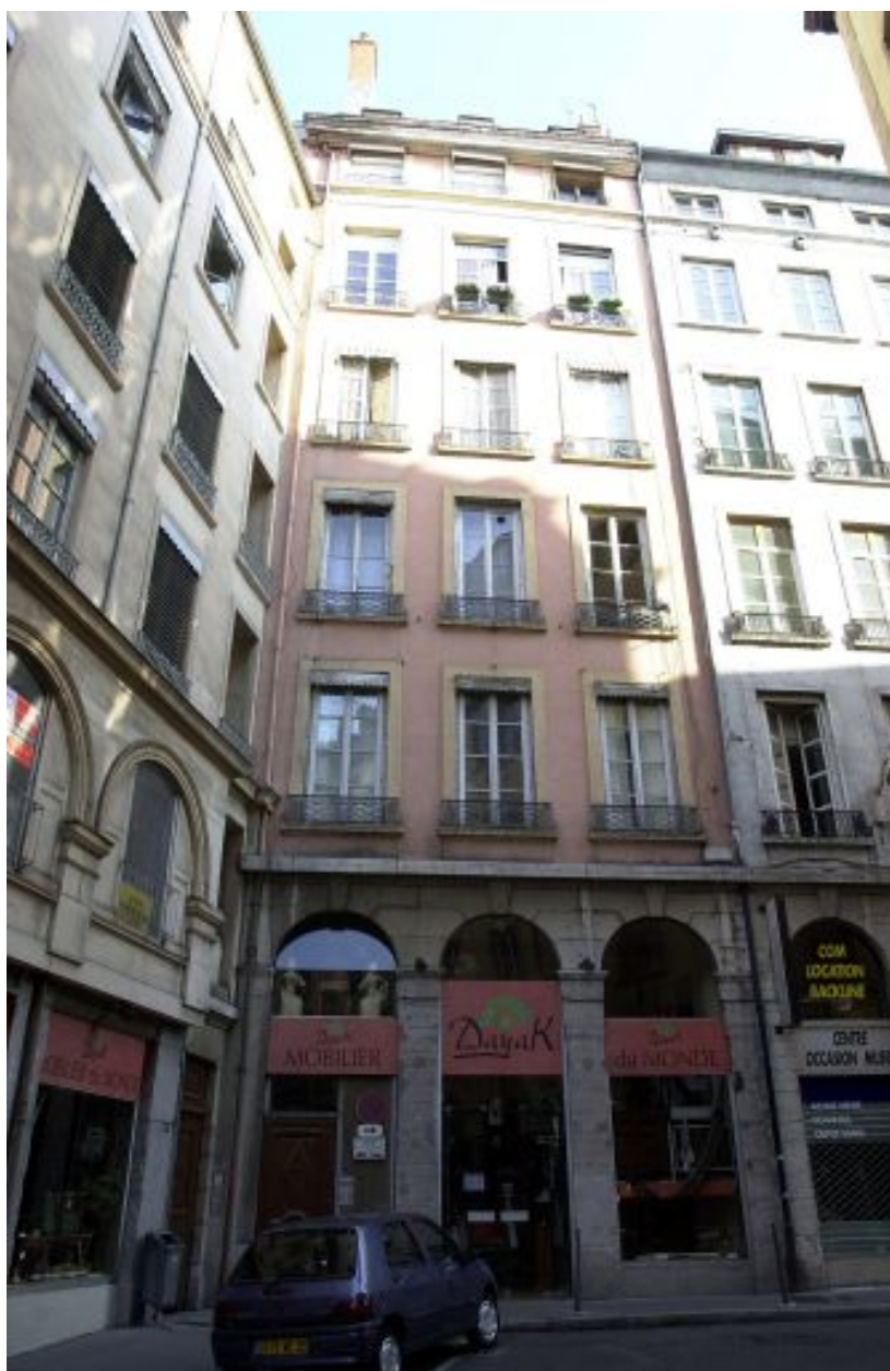
Façade principale, rue Chavanne
