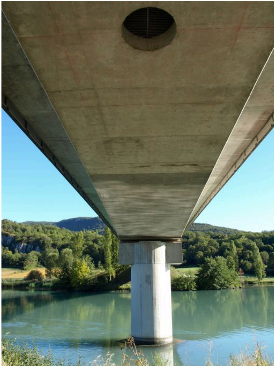
Vue sous le tablier (depuis la rive gauche)
