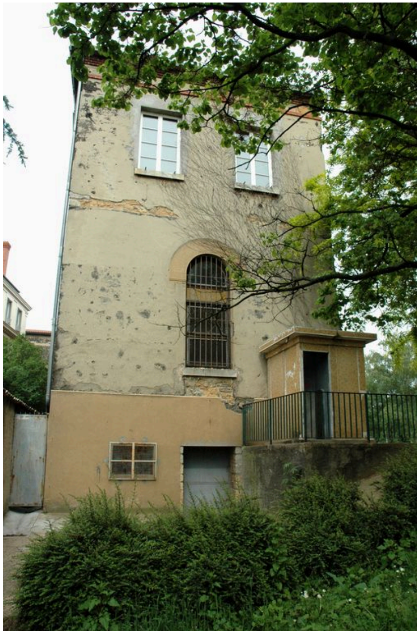
Bâtiment de la galerie, avant-corps ouest, élévation latérale
