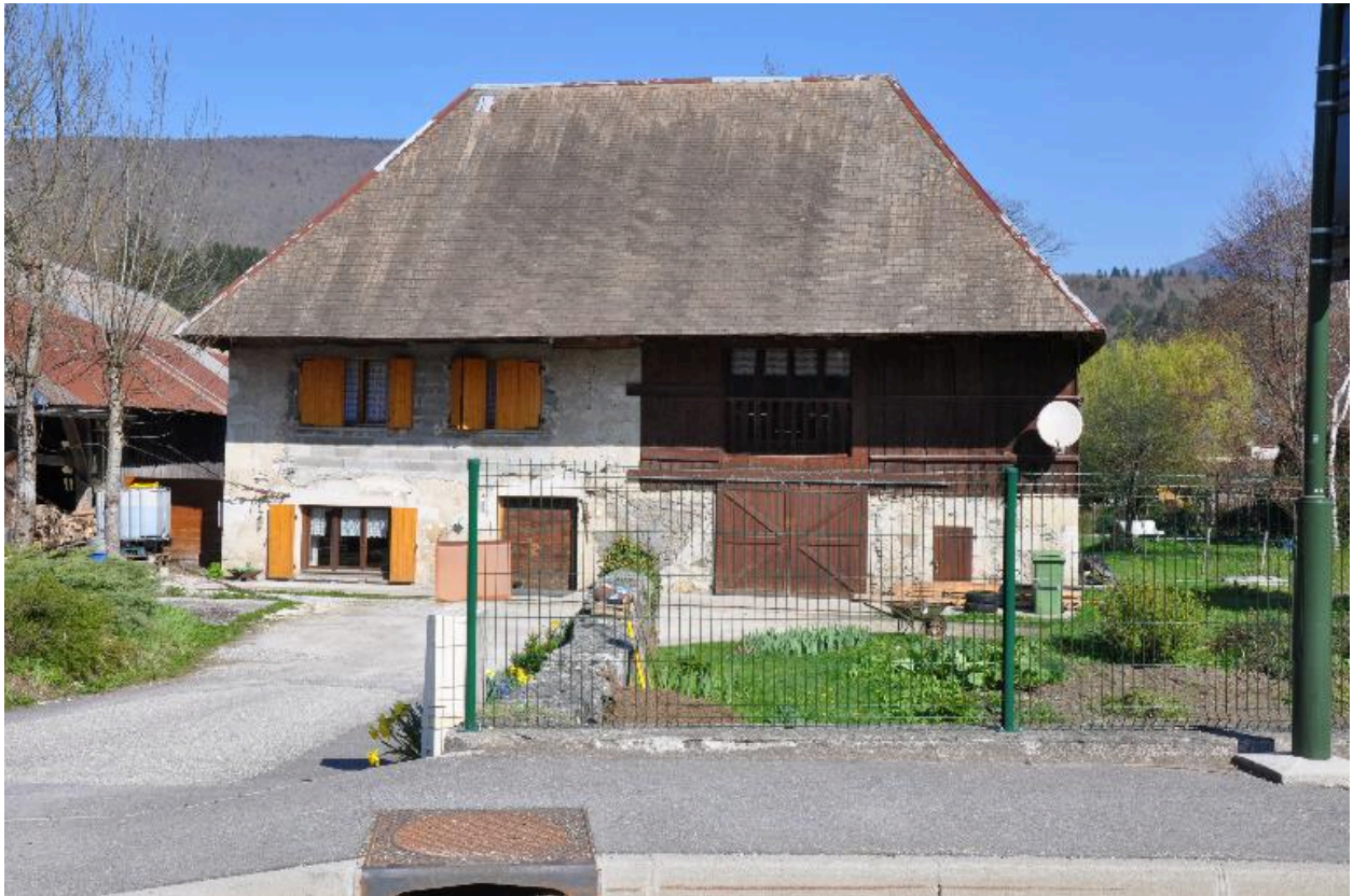
Vue du moulin aval.
