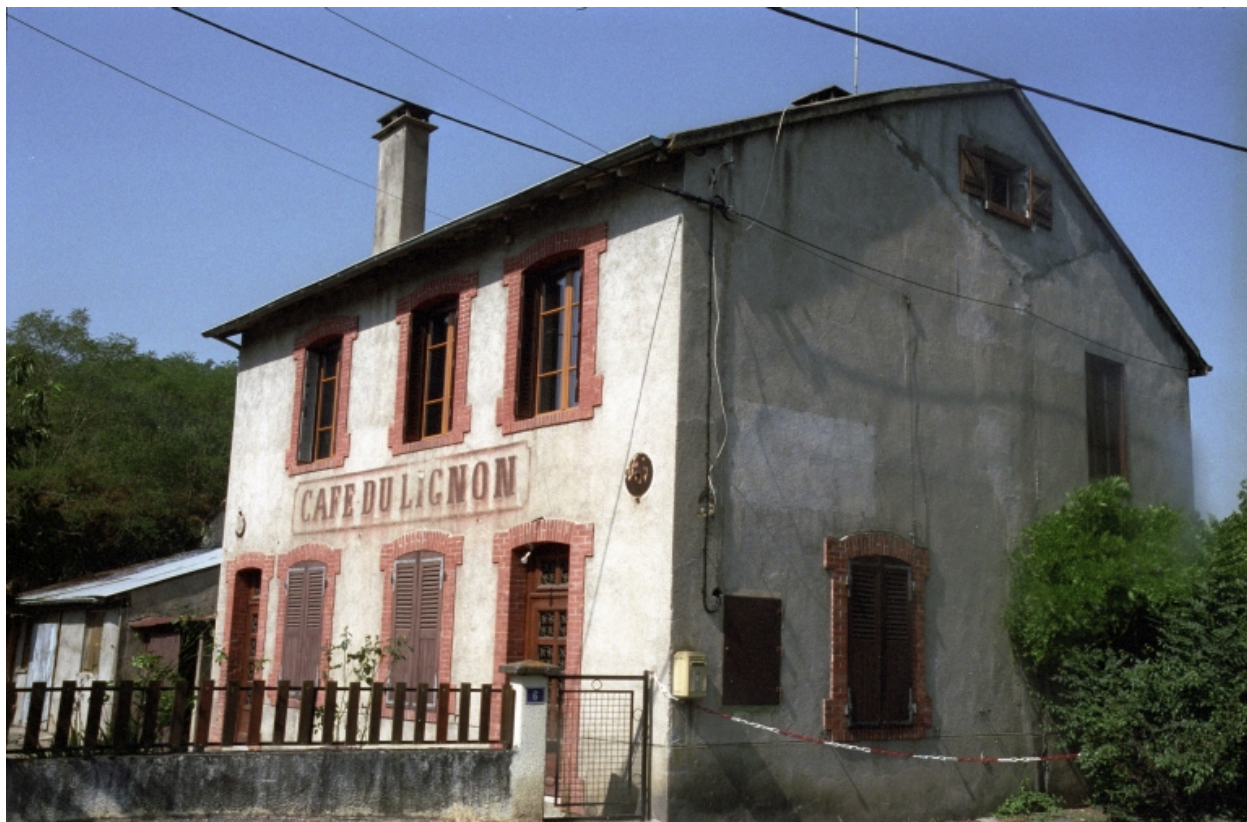
Boën, îlot 22, L'Argentière (rue de) - parcelle AP 46. Vue générale de la façade sur rue.
