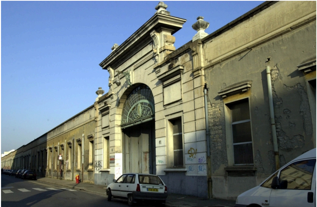
Détail entrée principale rue Feuillat
