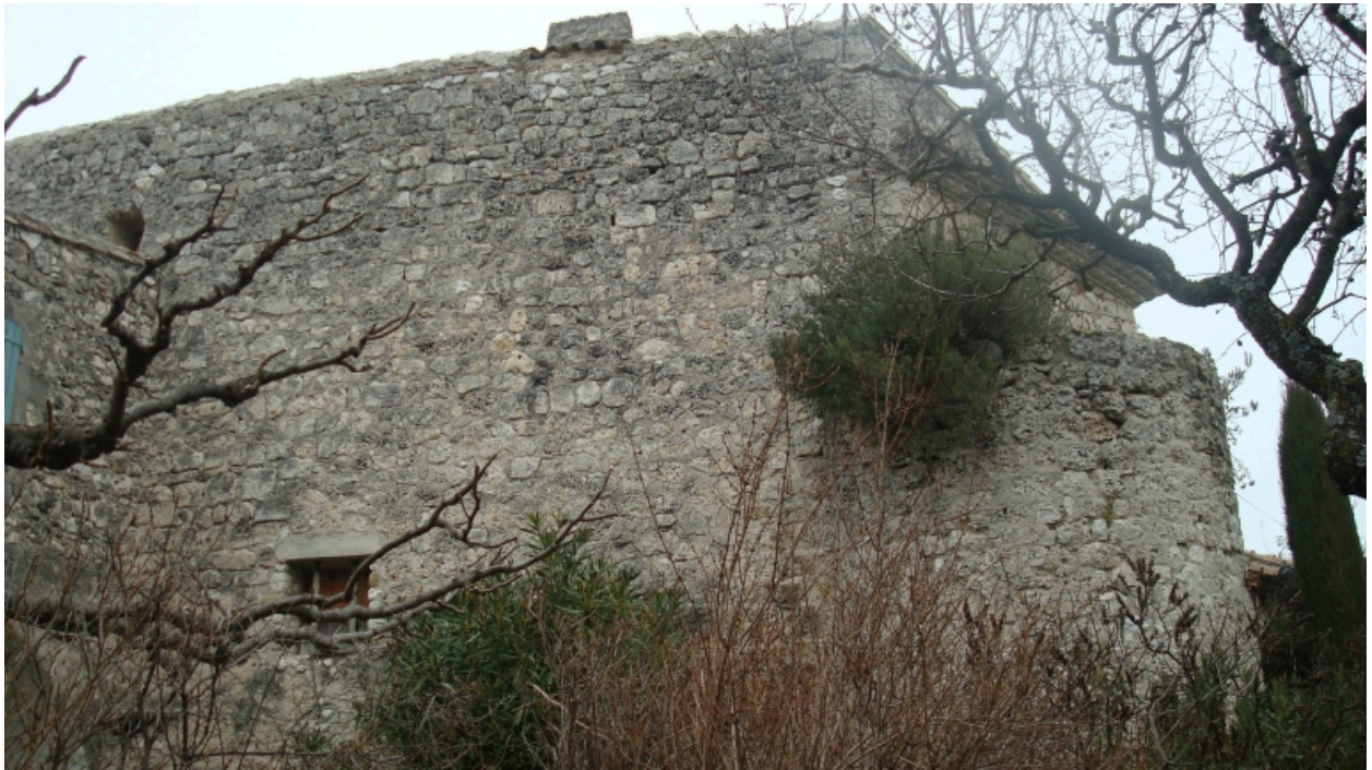
Partie sud de l'élévation postérieure, correspondant à l'ancienne courtine.
