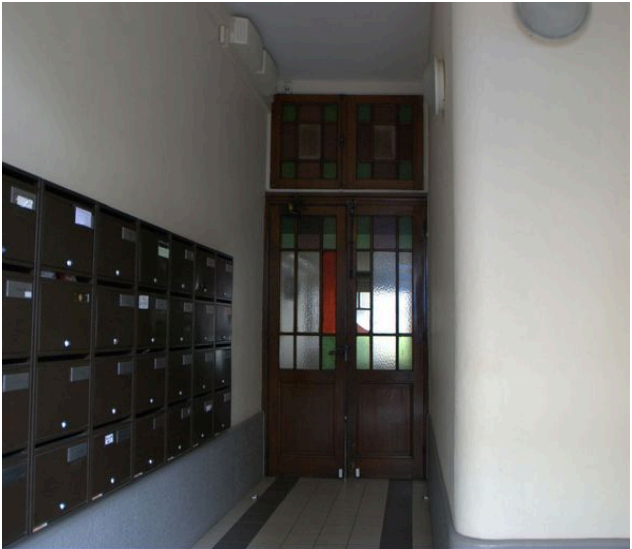
Vue de la porte du vestibule depuis l'intérieur
