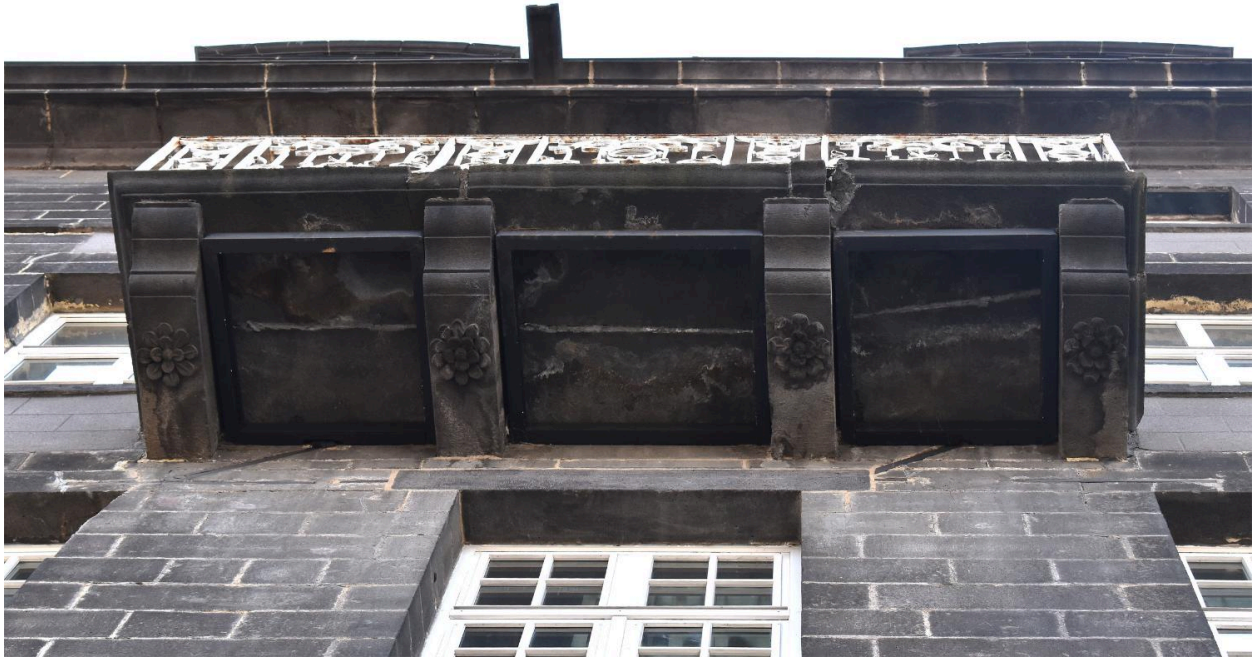
Pavillon est : détail des consoles soutenant le balcon
