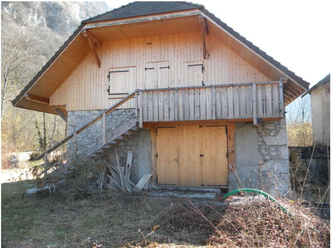
Vue d'ensemble d'un ancien moulin transformé.
