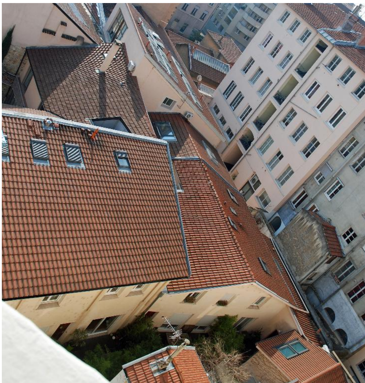
Vue partielle des bâtiments en coeur d'îlot
