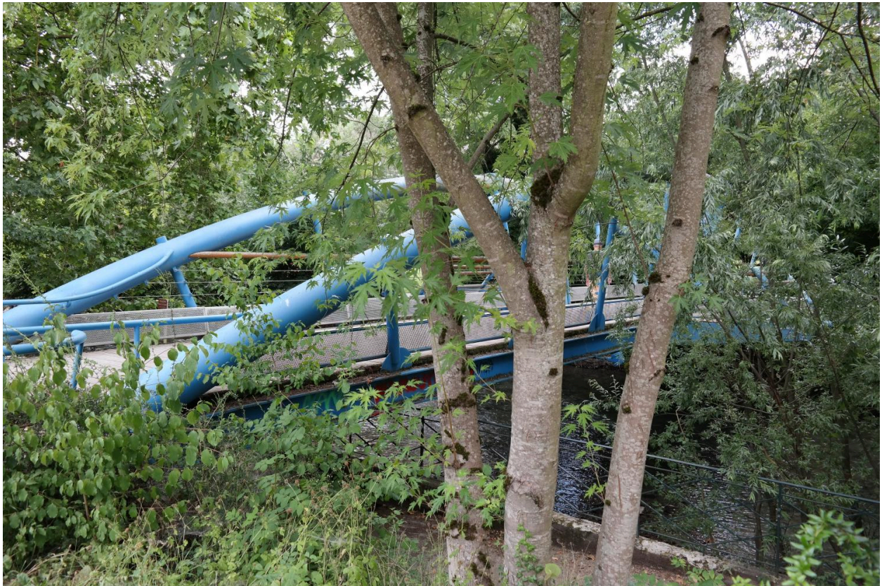
Passerelle piétonne sur le Thiou, vue de la face aval
