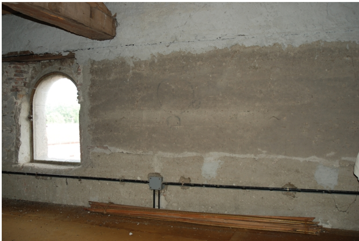
Vue intérieure du comble.
