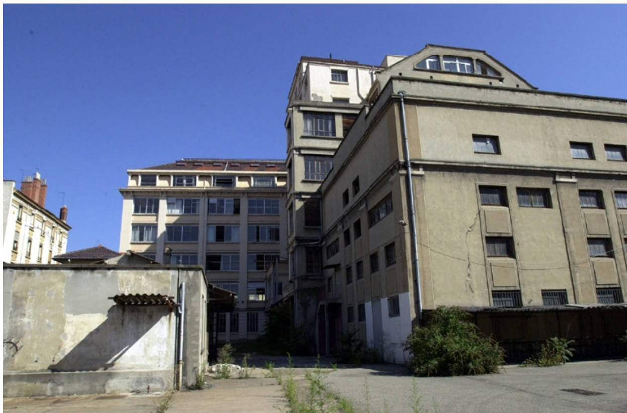
Vue d'ensemble est
