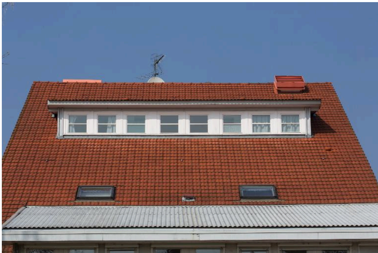
Bât. A : détail d'une rangée de lucarnes retroussées continues
