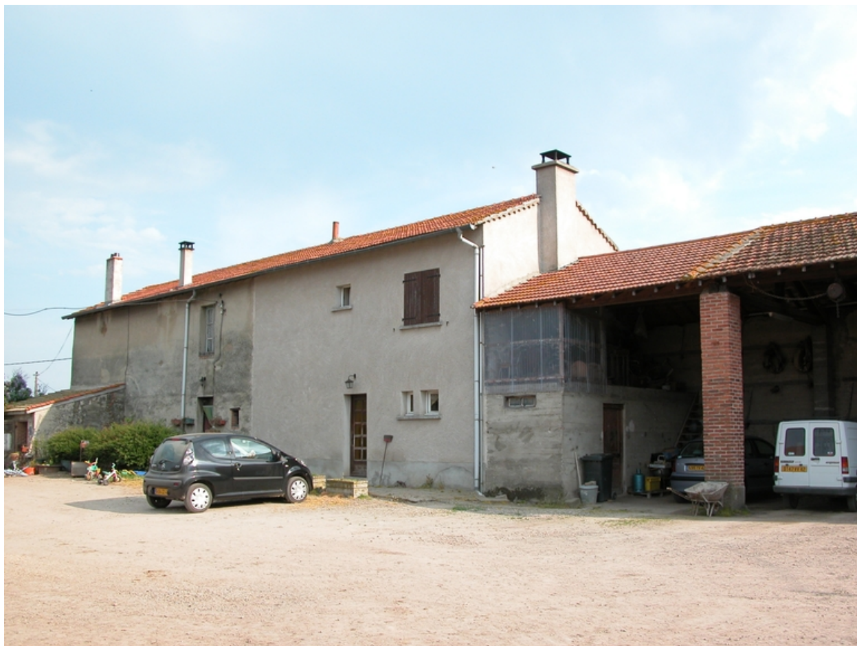
Vue d'ensemble du bâtiment sud : logis, hangar.
