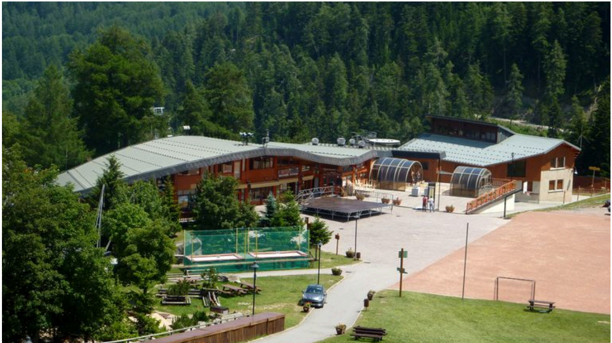
Vue depuis l'ouest
