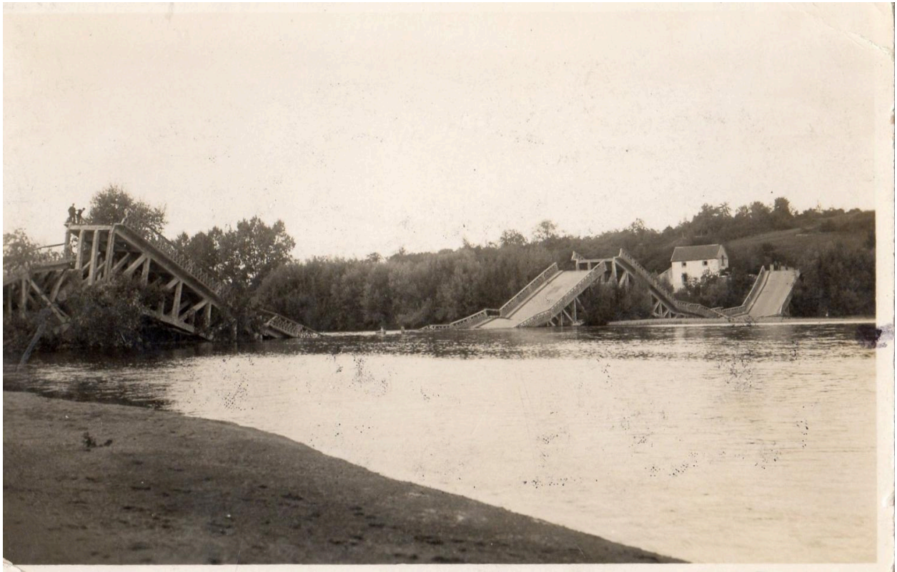
Vue du pont n°2 détruit le 7 septembre 1944. (Phot. Maurice Baës, photographe Lurcy-Lévy)
