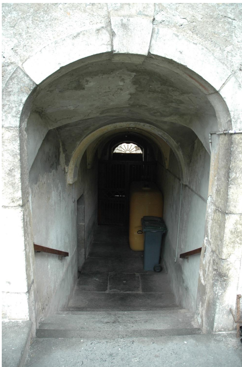
Vue intérieure du passage couvert reliant la cour à la rue, depuis le nord.
