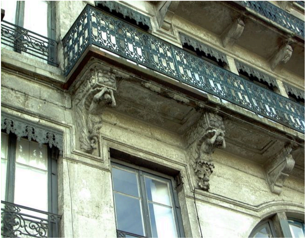
Détail du balcon et de ses supports, à gauche
