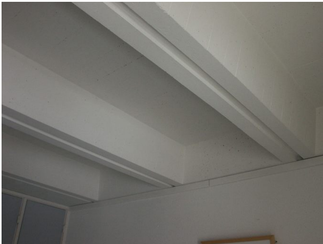
Une chambre. Détail du plafond
