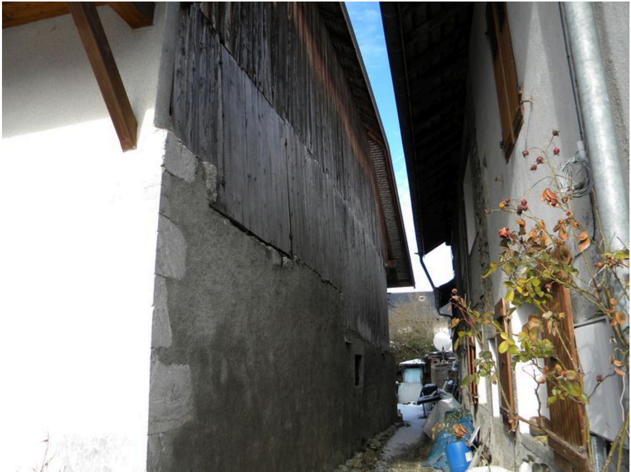
Vue du mur pignon est.
