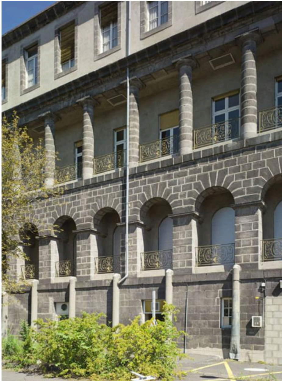
Hôtel-Dieu de Clermont-Ferrand. L'hôtel-Dieu, corps de bâtiment sud, travées de la façade sud.
