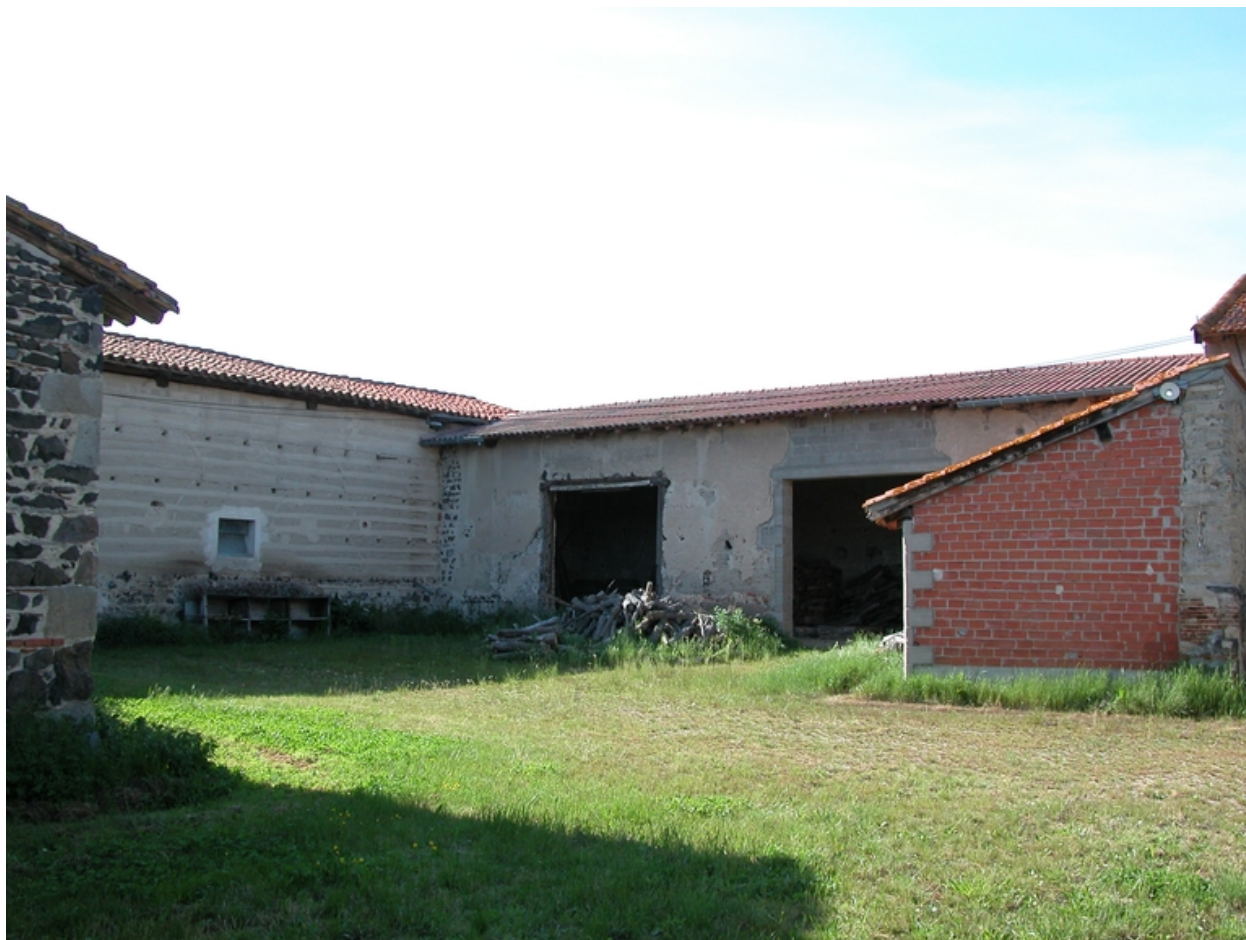
Vue de la petite grange-étable et du cuvage, depuis la cour.
