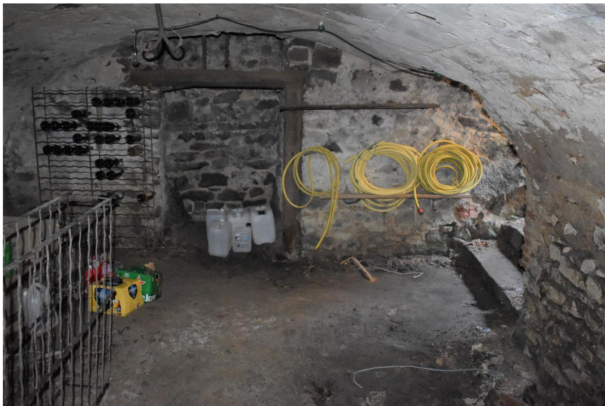
Vue d'ensemble vers l'ouest de la cave voûtée en berceau située en-dessous de l'arrière salle du rez-de-chaussée.
