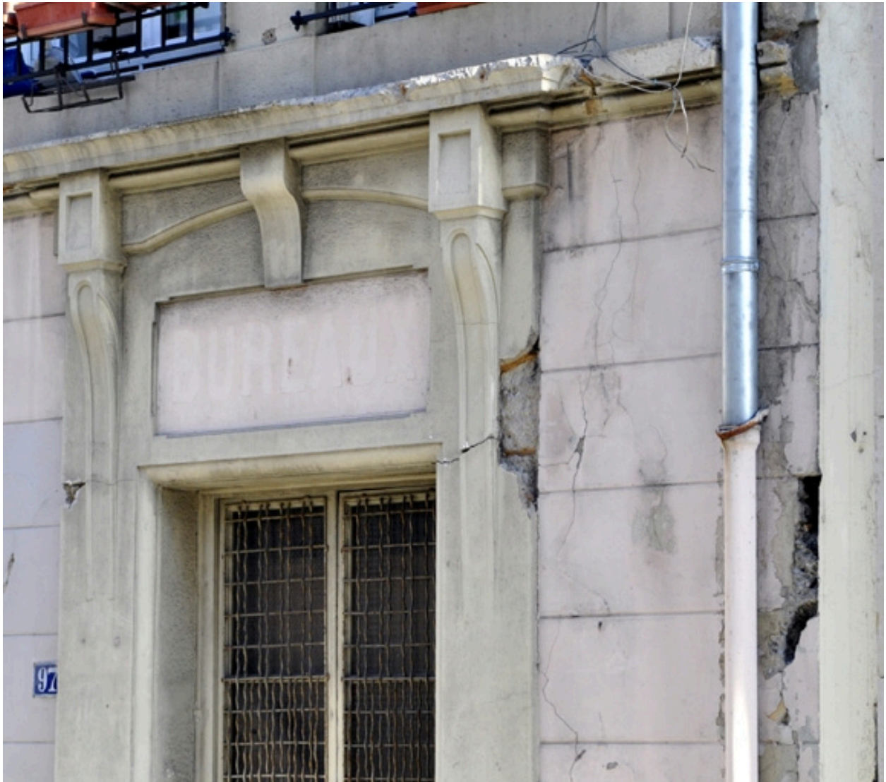
Détail enseigne Bureaux
