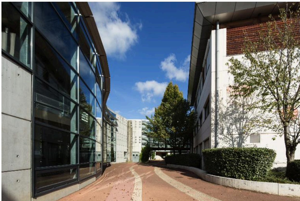
Bâtiment A et E
