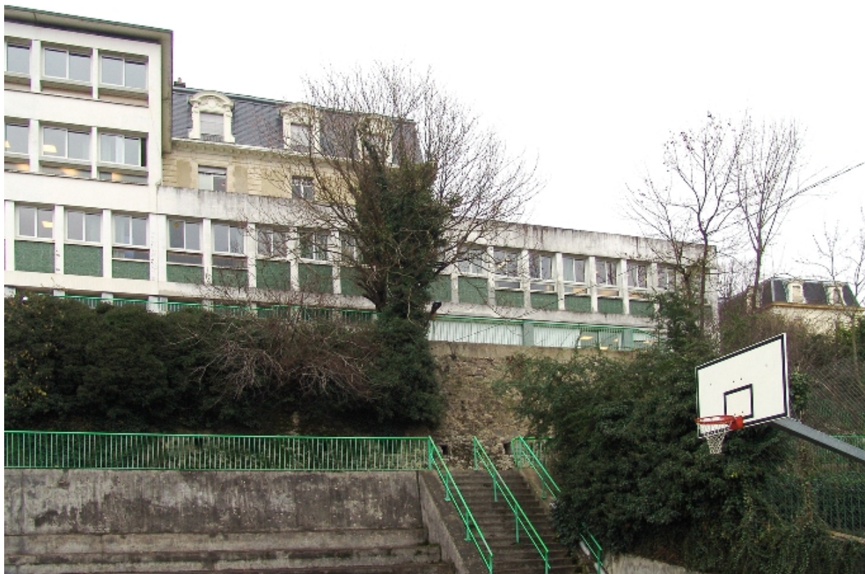
Bâtiment de 1962 : façade sur jardin, partie sud
